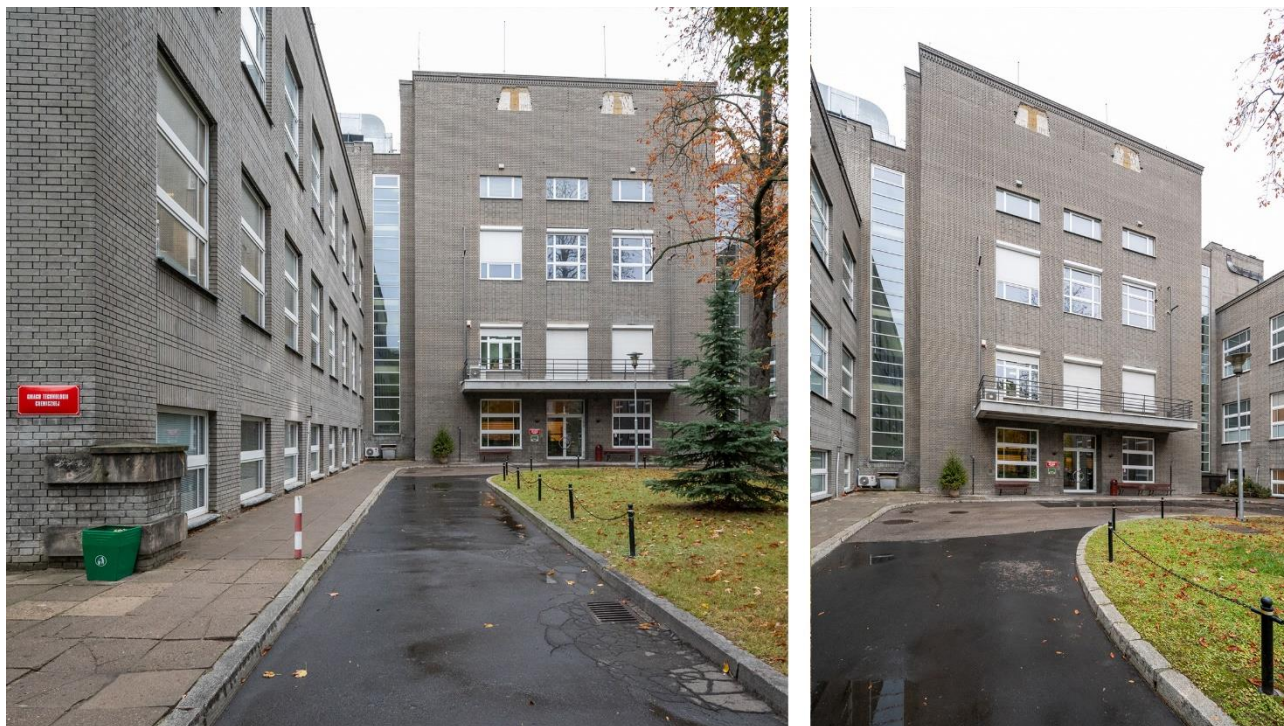
Zdjęcie 2 Widok na chodnik biegnący przed wejściem do budynku.
