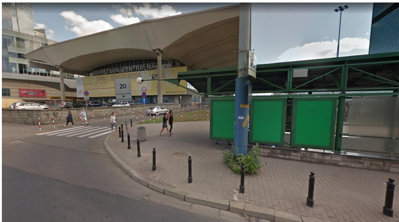
Zdjęcie 4 - Widok na chodnik w stronę wejścia głównego na dworzec Warszawa Centralna.
